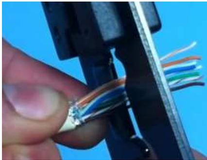
Cortar los cables, de modo que quede un largo del ancho de un dedo.
